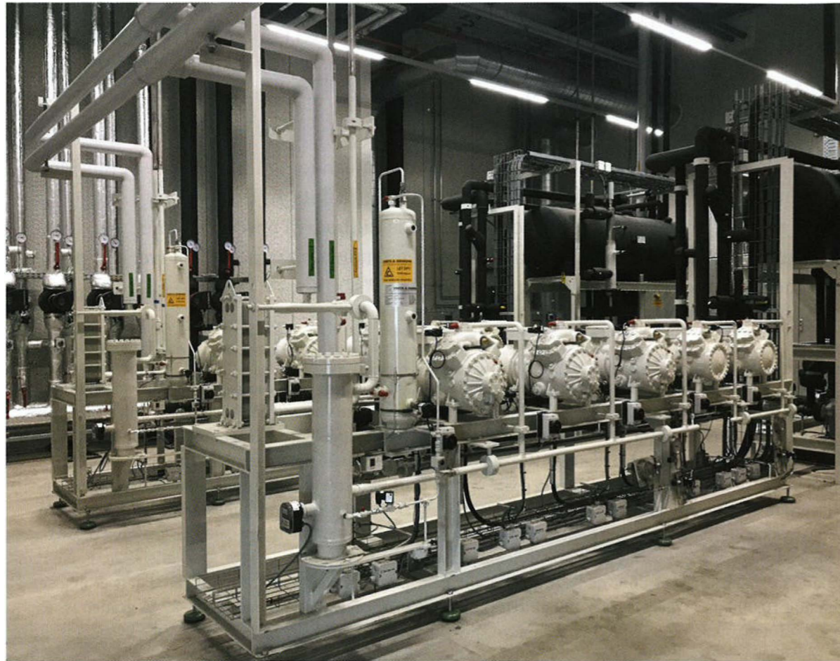
De koelcellen en vriescellen worden gekoeld door een transcritische CO 2 -koelmachine.
